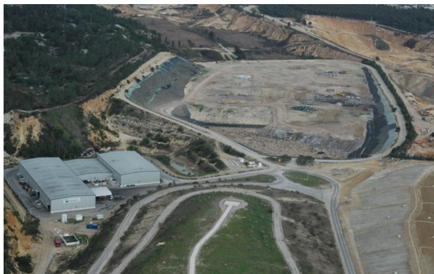
Figura 3 – Imagem aérea do Aterro do Ecoparque de Seixal
