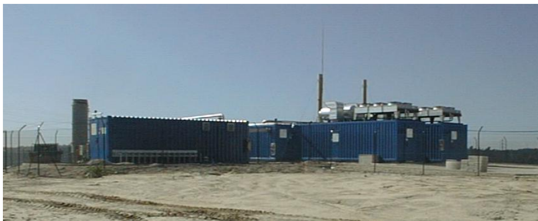
Figura 6 – Unidade de Aproveitamento Energético de Biogás do Ecoparque no Seixal.
