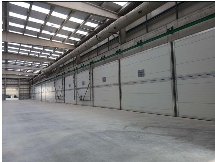
**Figura 3.** Túneis de compostagem intensiva
