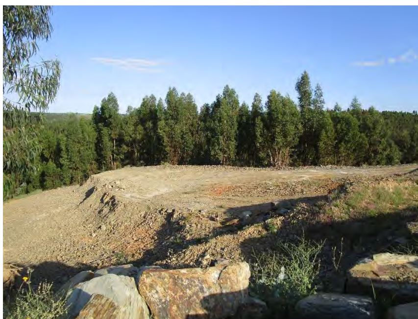
Figura 2 - Vista geral do aterro (solo artificializado)
