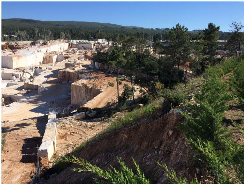
Figura 10. – Talude existente entre a habitação e a lavra
