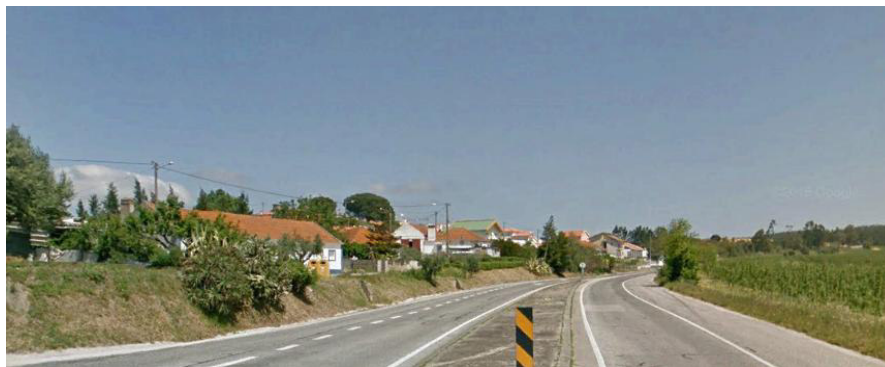
Edificações existentes no lugar das Marés, junto à estrada N1/IC2, com visibilidade para o Projeto
