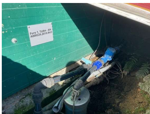
Foto 1: Cotador à saída do furo 1
