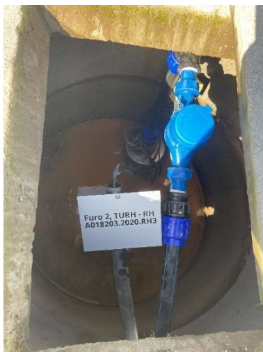
Foto 2: Cotador à saída do furo 2
