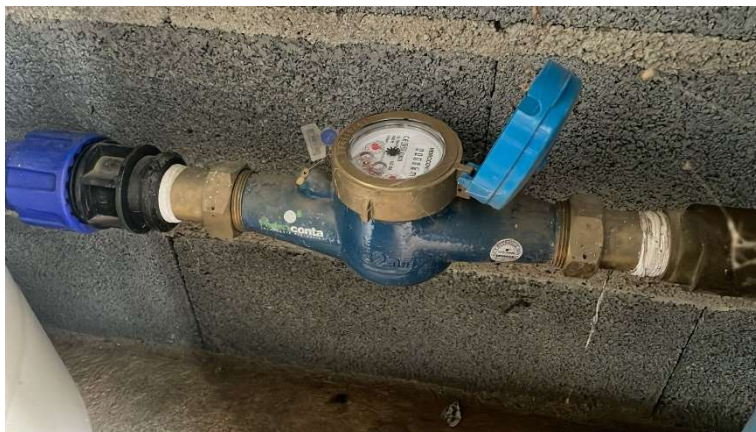
Foto 6: Contador situado no depósito de armazenamento da água da nascente.
