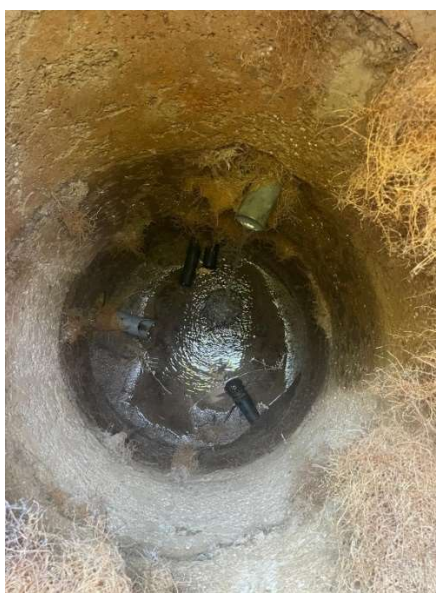
Foto 5: Acesso criado para limpeza dos drenos das águas da nascente
