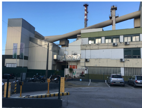
Imagem 2.3 - Vista do ponto de medição em direcção à GALLOVIDRO.
