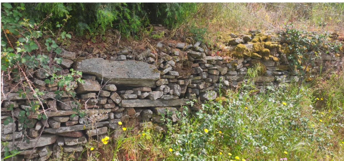
Figura 146: Muros de socalco feitos de placas de xisto, existentes na encosta meridional.
