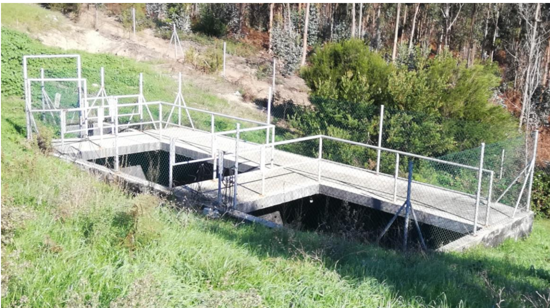
Figura 2 – Tanque de equalização e elevação dos lixiviados das células B e C
