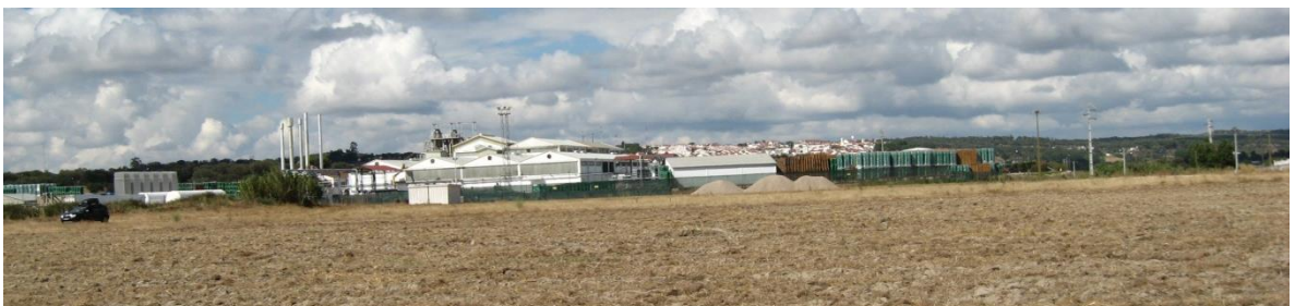
Fotografia 4.21 Vista da Unidade Fabril de transformação de Tomate
