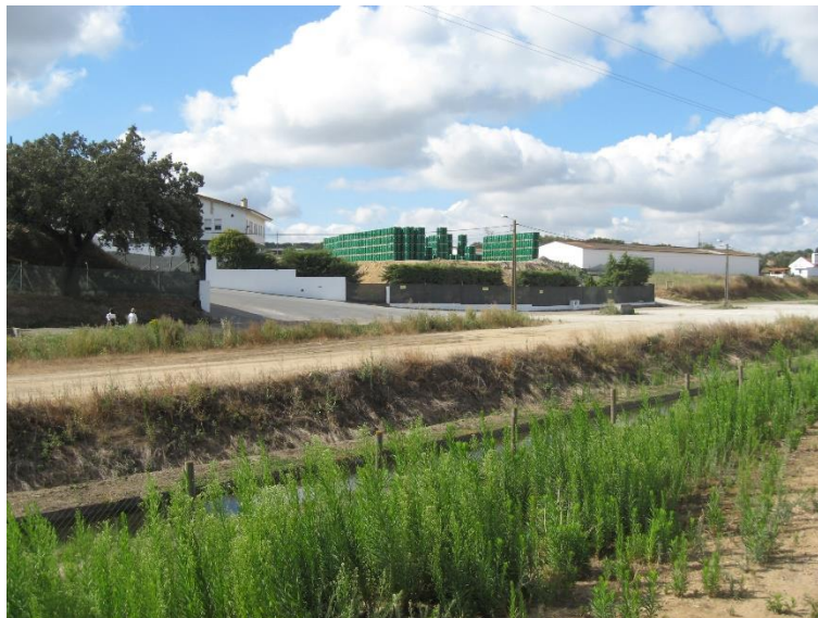
Fotografia 4.7 Área artificializadas na área de estudo. Em primeiro plano canal de rega e em segundo acessos e área fabril
