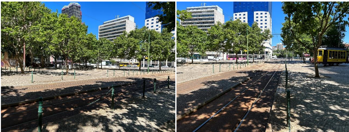
Praça principal de entrada na CE, onde ocorre a implantação do elevador de acesso à superfície
