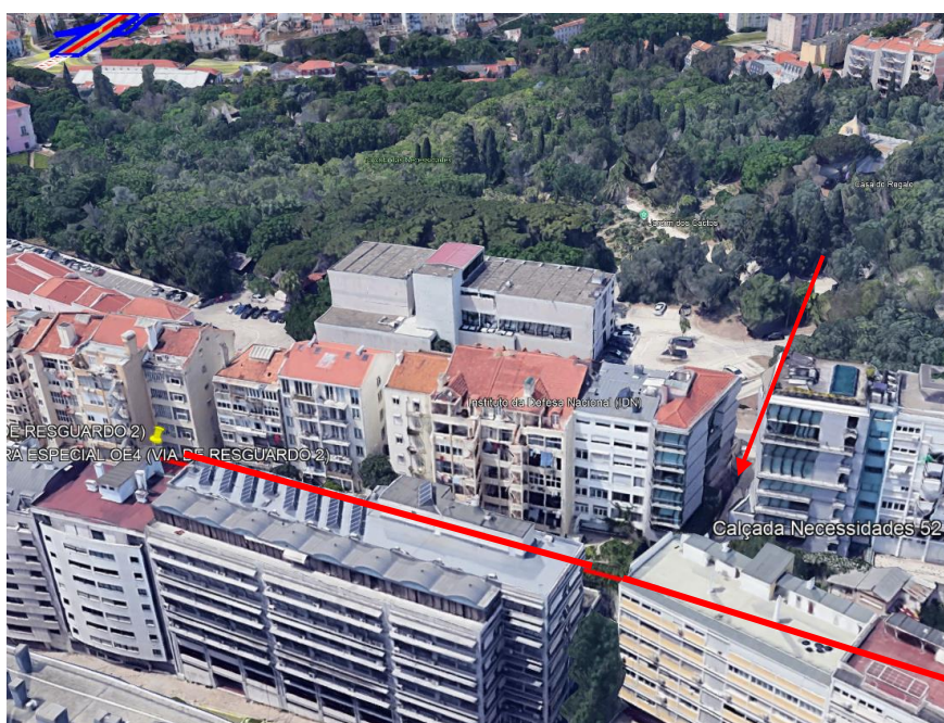
Foto 1 – Vista envolvente ao troço do Aqueduto do EPAL
