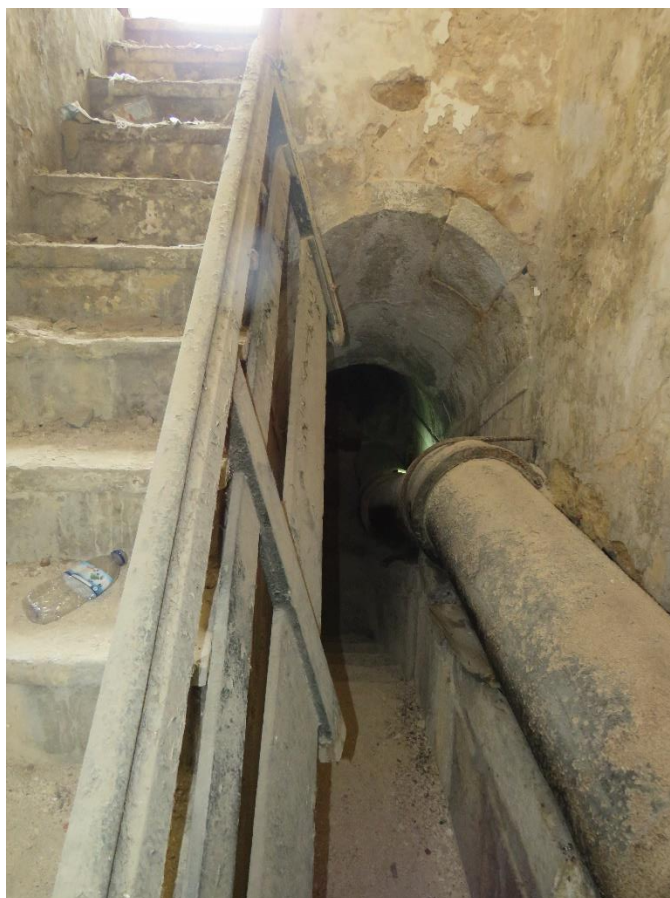
Foto 2 – Vista do interior do aqueduto de W para E pela entrada
