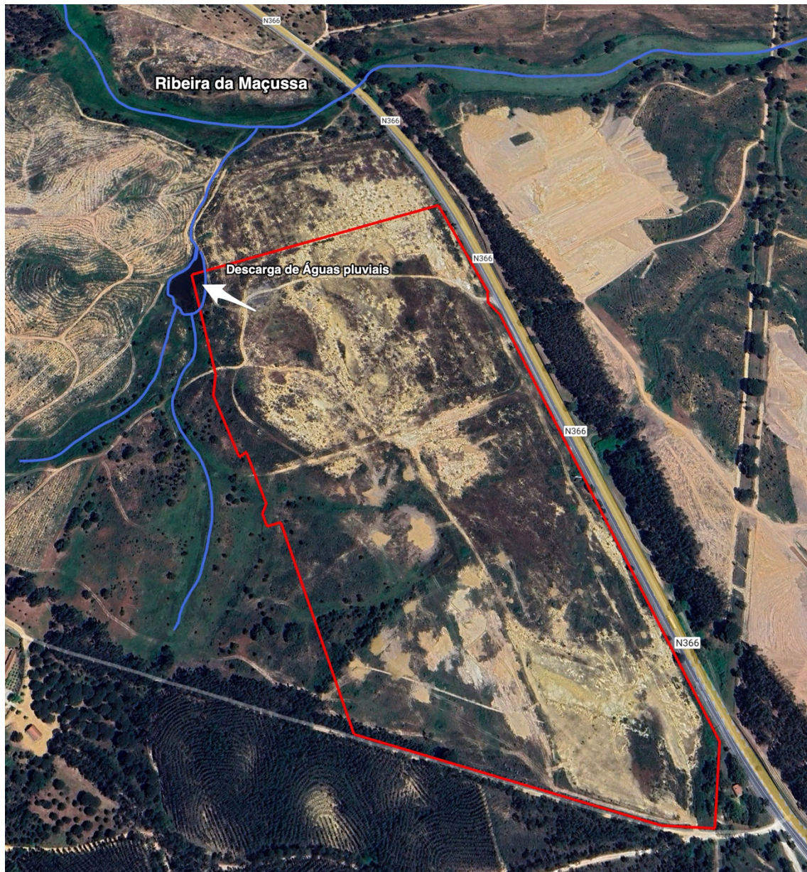
Figura 3.16 – Ponto de descarga das águas pluviais e linhas de água recetoras.
