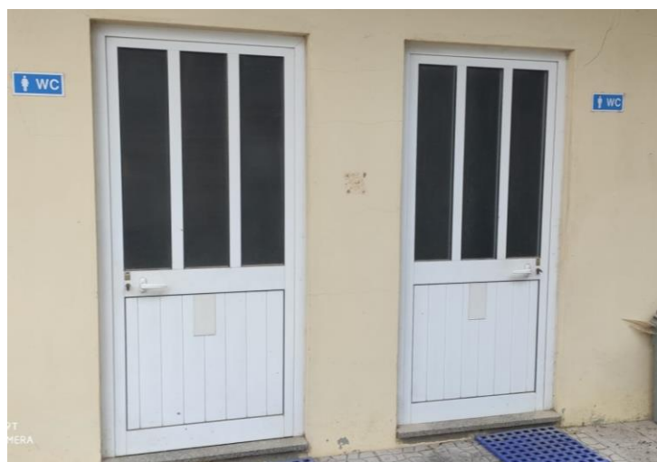
Figura 1. Filtro sanitário da instalação avícola da Solovo
