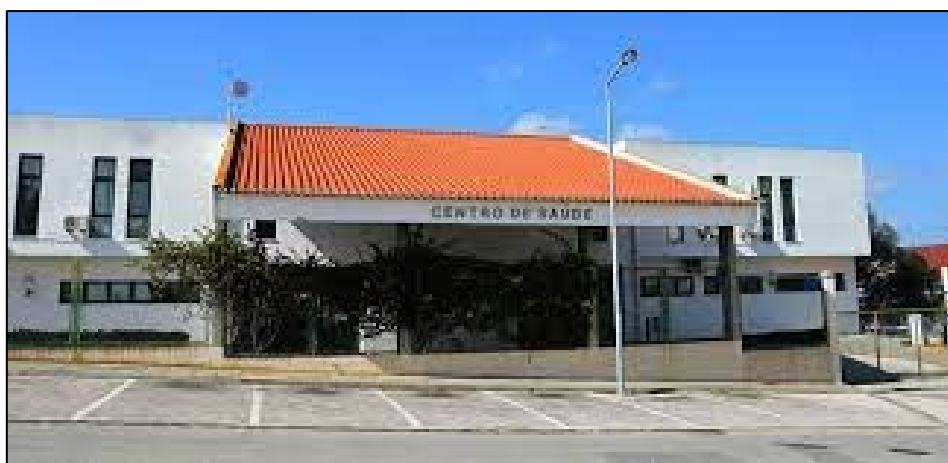
Figura 58. Centro de Saúde de Lagoa FONTE: CM DE LAGOA
