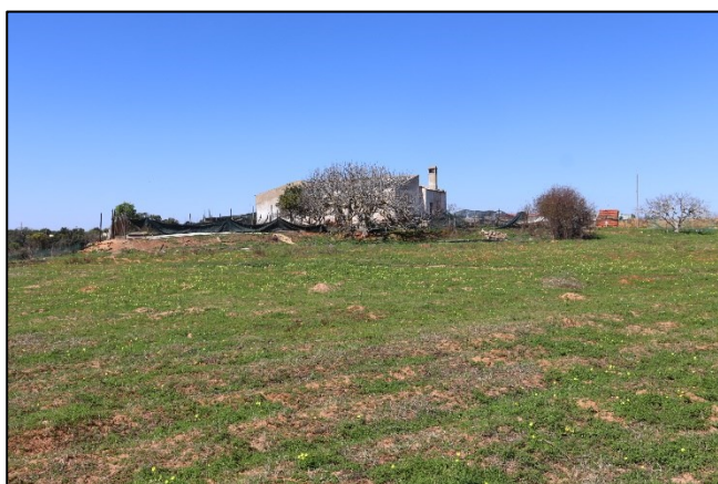
Casa de habitação abandonada na área de projeto
