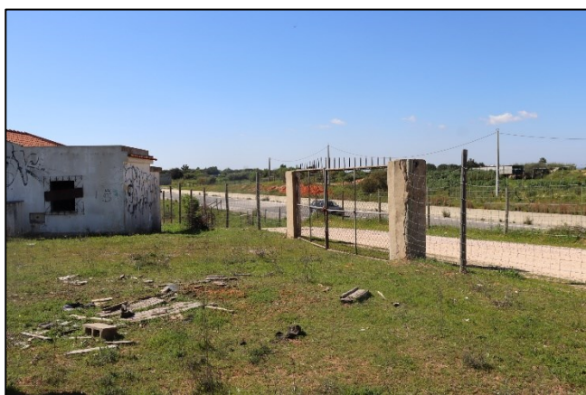
Entrada a norte da área de projeto, com antiga habitação (abandonada)
