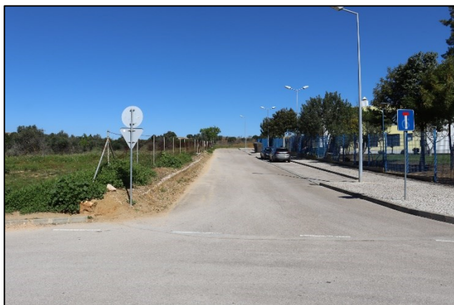
Impasse da Rua do Centro de Saúde na área de projeto ( a partir do qual se pretende desenvolver a rede viária, na sua continuidade)
