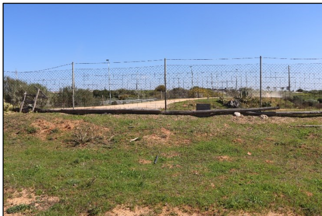
Vedação norte da área de projeto, serventia e via de acesso a Lagoa da A22
