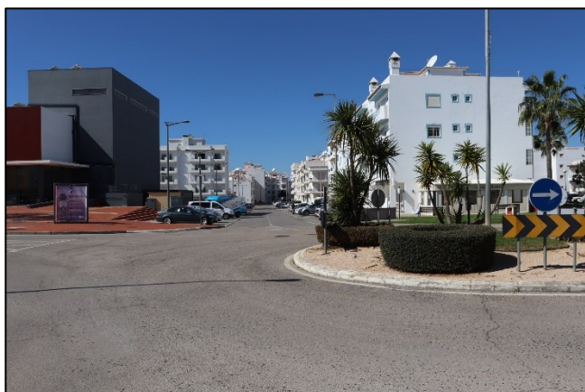
Envolvente – Perspetiva sobre a Rua Carlos Alberto Correia Ribeira, ladeada pelo auditório e edifícios plurifamiliares
