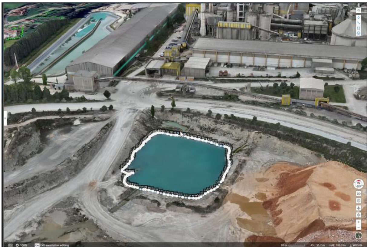
Figura 3 – Vista das duas bacias de decantação LT4
