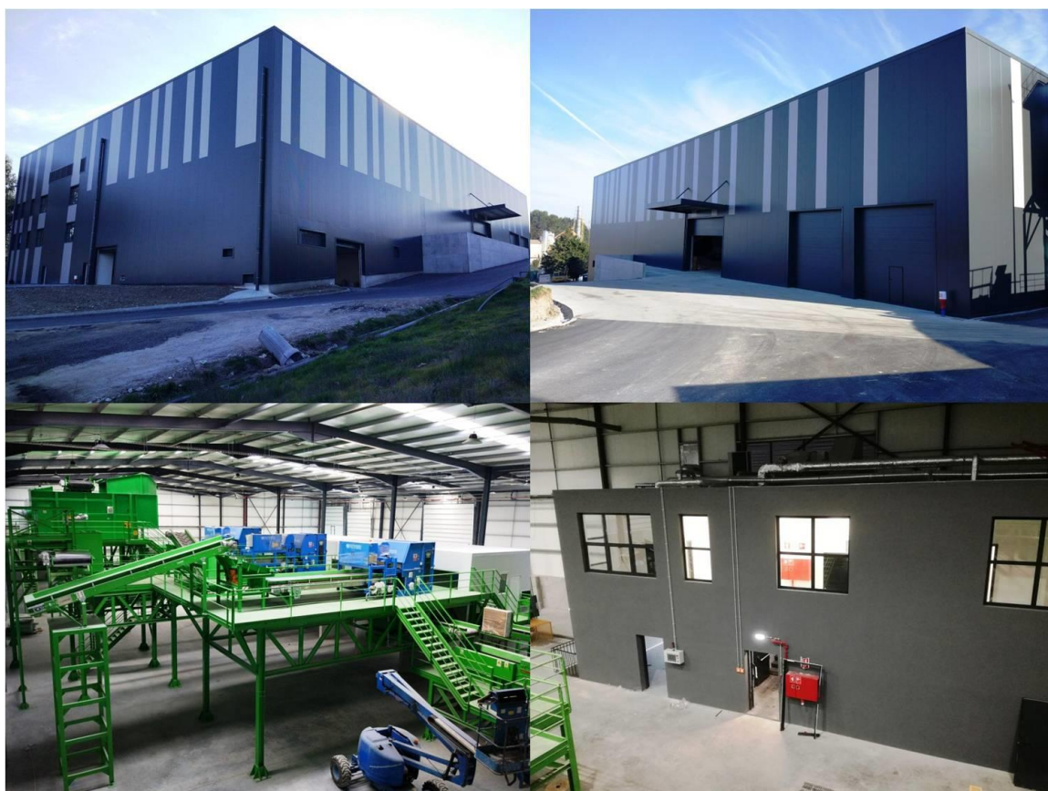
Figura 9 – Imagens da nova Unidade de Triagem de Lustosa
