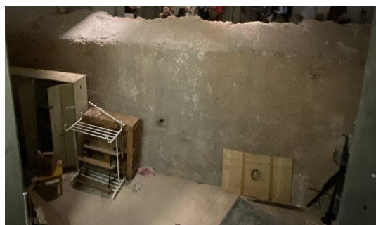
Figura 7 – Fotografia ilustrativa de parte da muralha filipina/espanhola atualmente preservada no interior do edifício da casa de Goa, interferência N° 381c
