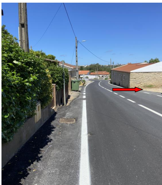
Foto 5 – Aspeto das excelentes condições do piso alcatroado da estrada Lagar dos Frades junto à entrada da pedreira (seta vermelha).
