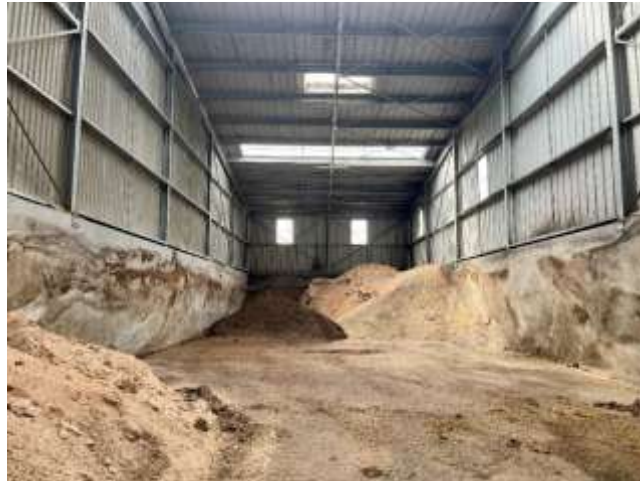
Fotografia 3 – Exemplo de plataforma tipo silo, para armazenamento de estrumes
