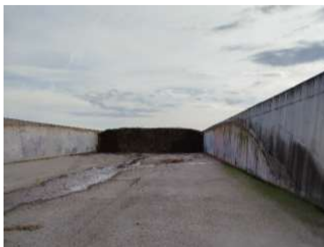
Fotografia 4 – exemplo de plataforma tipo silo exterior para armazenamento de vegetais
