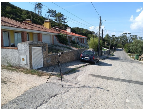
Figura 10.1.1 – Ponto de controlo nos edifícios em banda a Sul da Rua Dona Maria Pia
