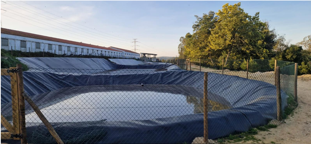
Lagoas impermeabilizadas com tela PEAD de 1,5mm de espessura e vedadas Folga mínima de 0,5 m
