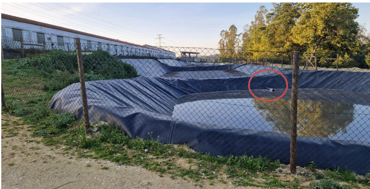
Lagoas impermeabilizadas com tela PEAD de 1,5mm de espessura e vedadas Folga mínima de 0,5 m
