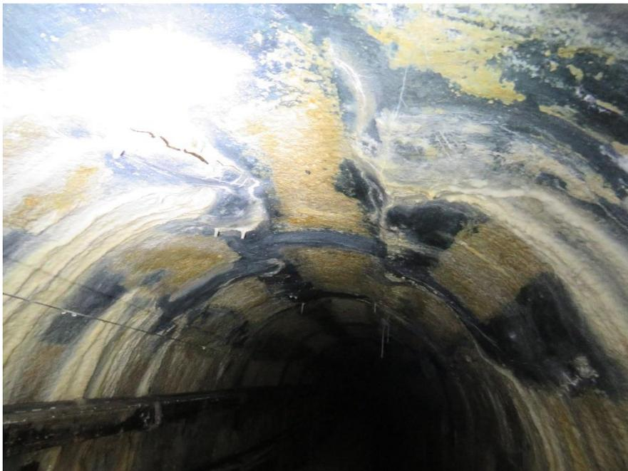
**Foto 3 – Estado do hasteal do Aqueduto ao PK 0+315m da obra por infiltrações exteriores com incrustações calcárias**
