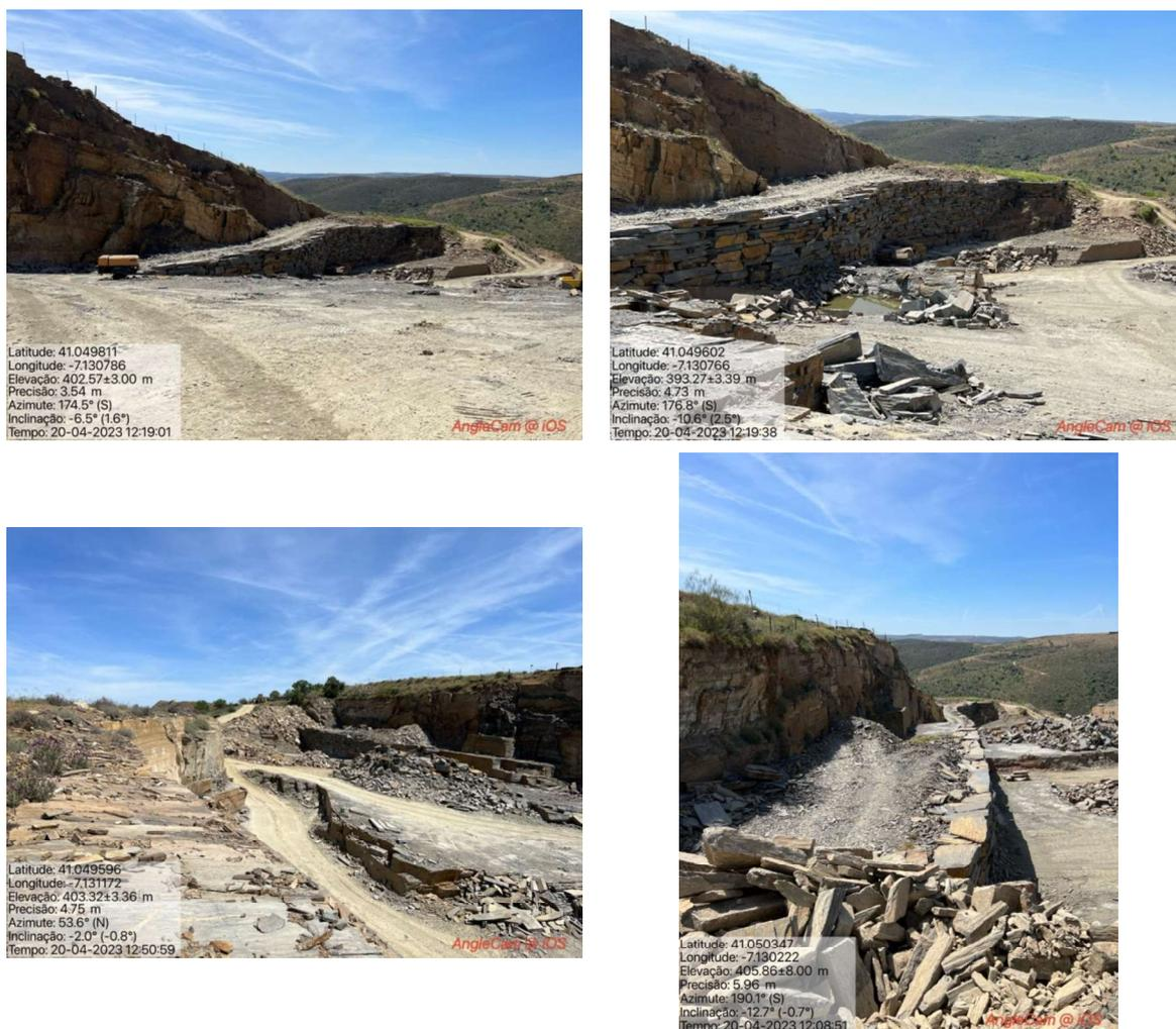
Figura 9: Fotografias do patamar implementado evidenciando a implementação da medida de suavização e estabilização dos taludes de inclinação acentuada com a criação de um patamar elevado na base.
