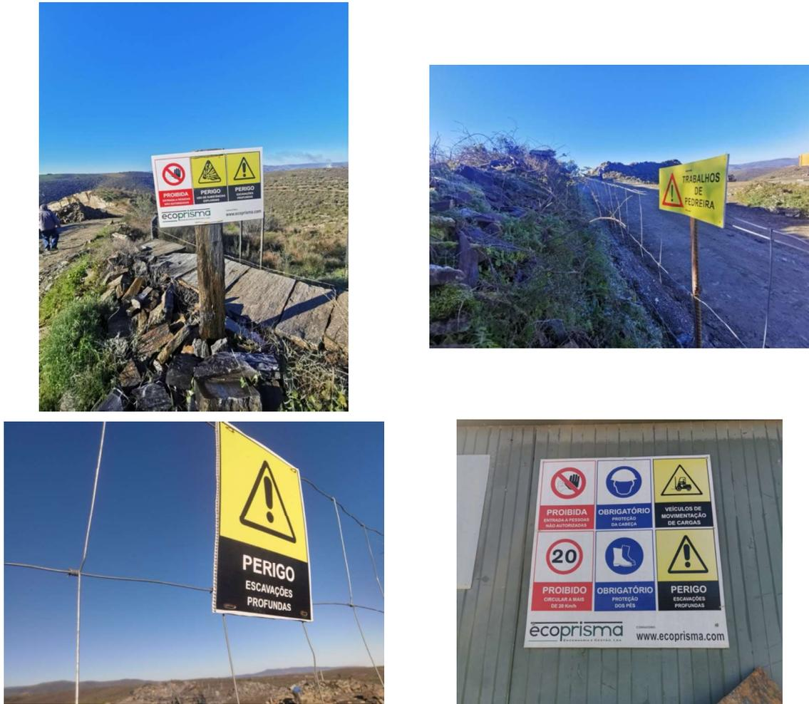
Figura 5: Fotografias da sinalização existente na Pedreira evidenciando a implementação da medida de sinalização dos locais que apresentam maior criticidade, no perímetro e no interior da pedreira.
