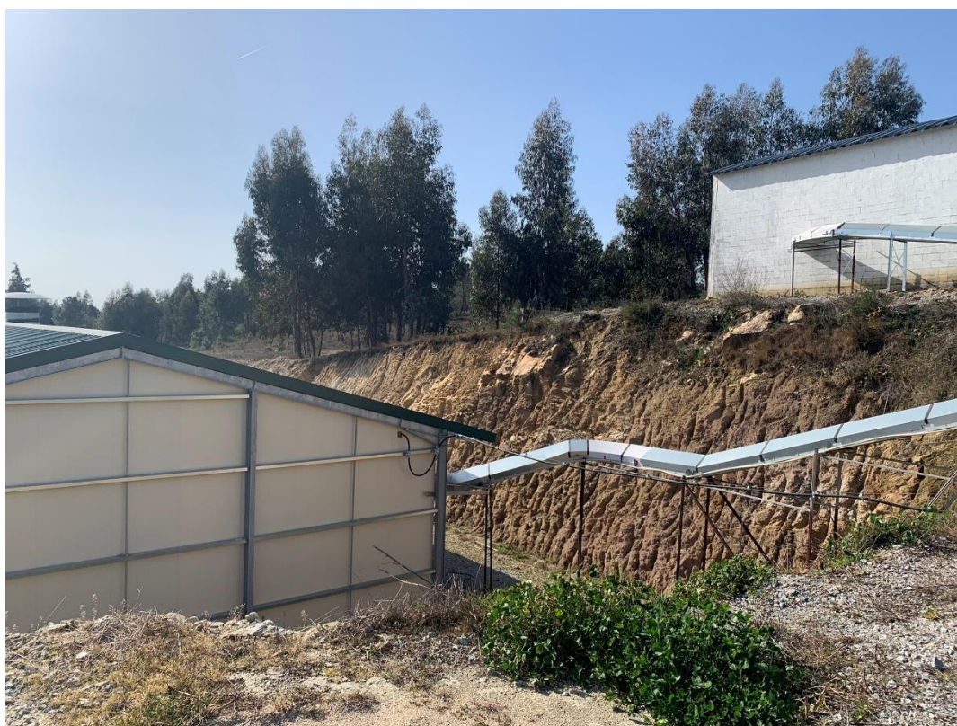
Figura 3.2.2. Pavilhão Avícola D e Sistema de Transporte dos Ovos
