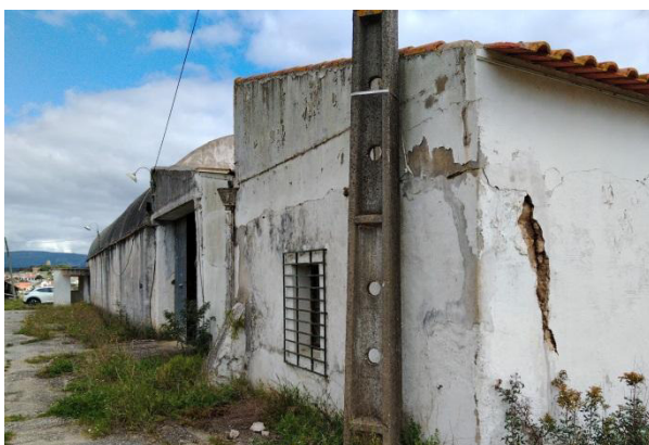
Fotografia 6.51 – Pormenores do edificado existente no setor sudoeste da AER [2]
