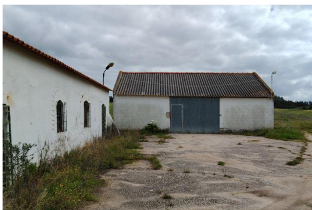
Fotografia 6.50 – Pormenores do edificado existente no setor sudoeste da AER [1]
