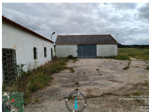
Fotografia 6.35 – Edificações em estado de abandono dentro da Área de Estudo [1]
