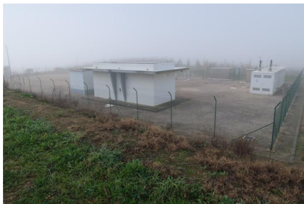
Fotografia 6.42 – Área terraplanada e infraestruturada
