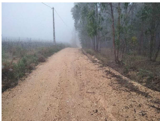
Fotografia 6.18 – Acesso em terra batida que limita a área de estudo
