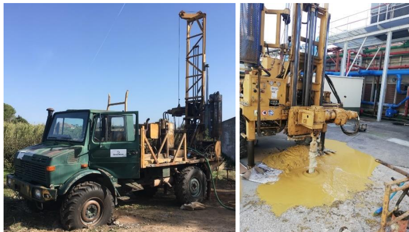
Figura 2.2 – Equipamento Mobile Drill , modelo B47-HD , montado em veículo todo-o-terreno Unimog
