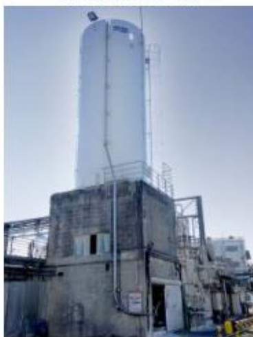
Silo sobre obra civil
