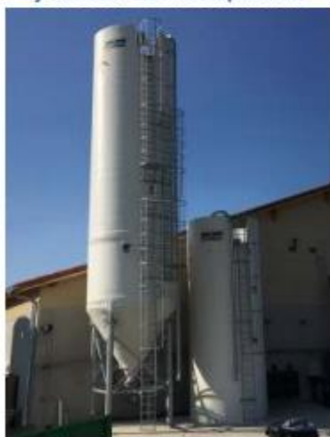
Silo con estructura y silo con faldón autoportante
