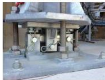
Células de carga del silo
