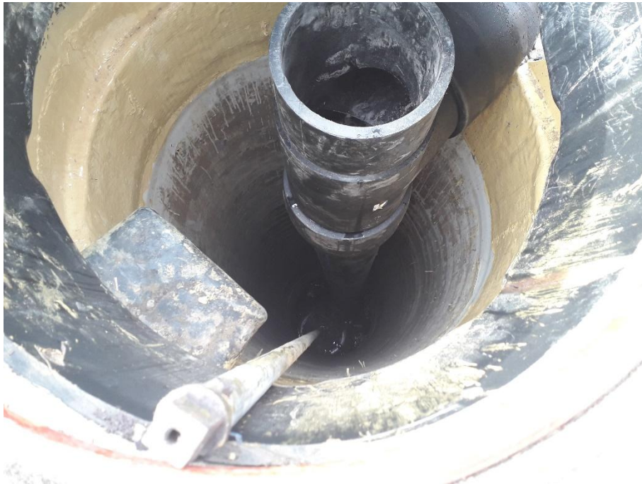
Encamisamento em tubagem PEAD 315mm
