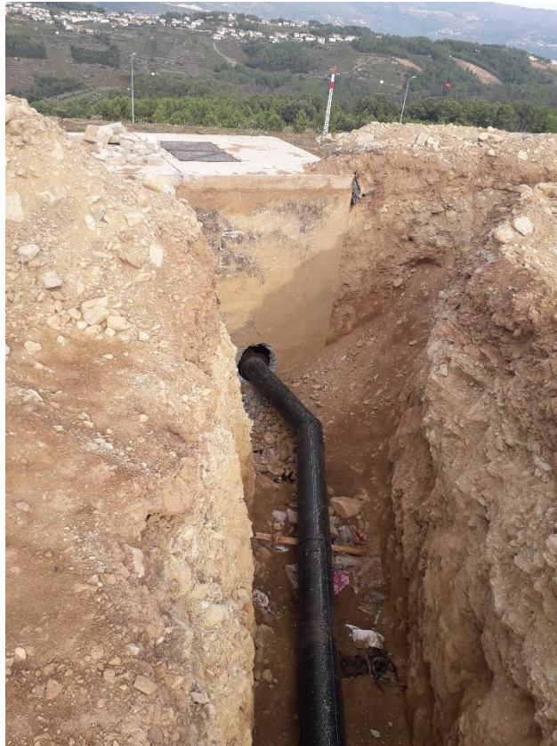
Ligação à estação elevatória - célula 2
