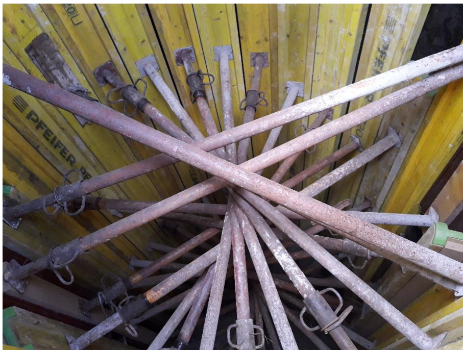
Trabalhos de substituição (durante intervenção)
