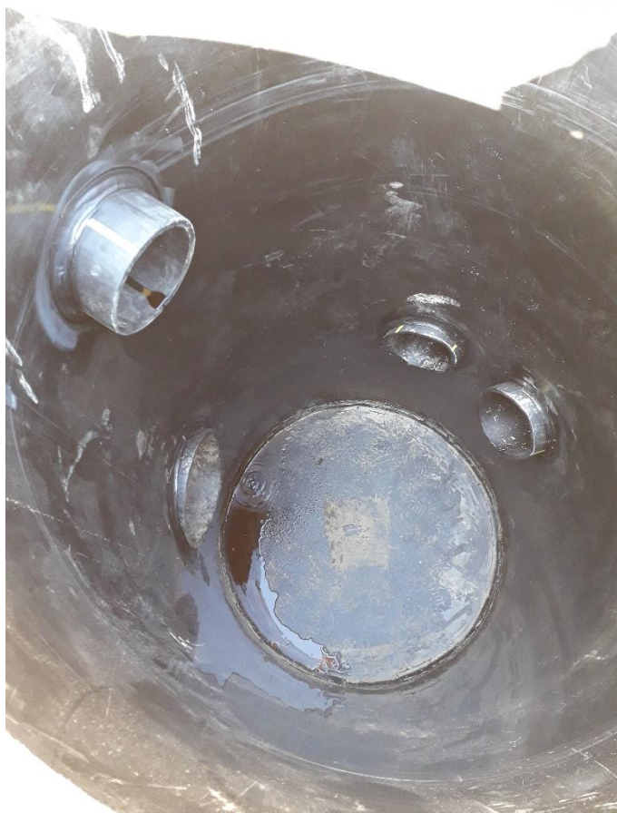
Estação elevatória com revestimento em placa PEAD f(final da intervenção)
