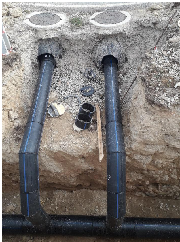
Ligação à estação elevatória - célula 2
