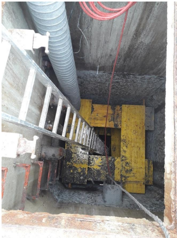
Estação elevatória em betão (antes da intervenção)
