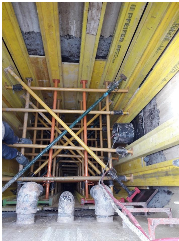
Trabalhos de revestimento (durante intervenção)
