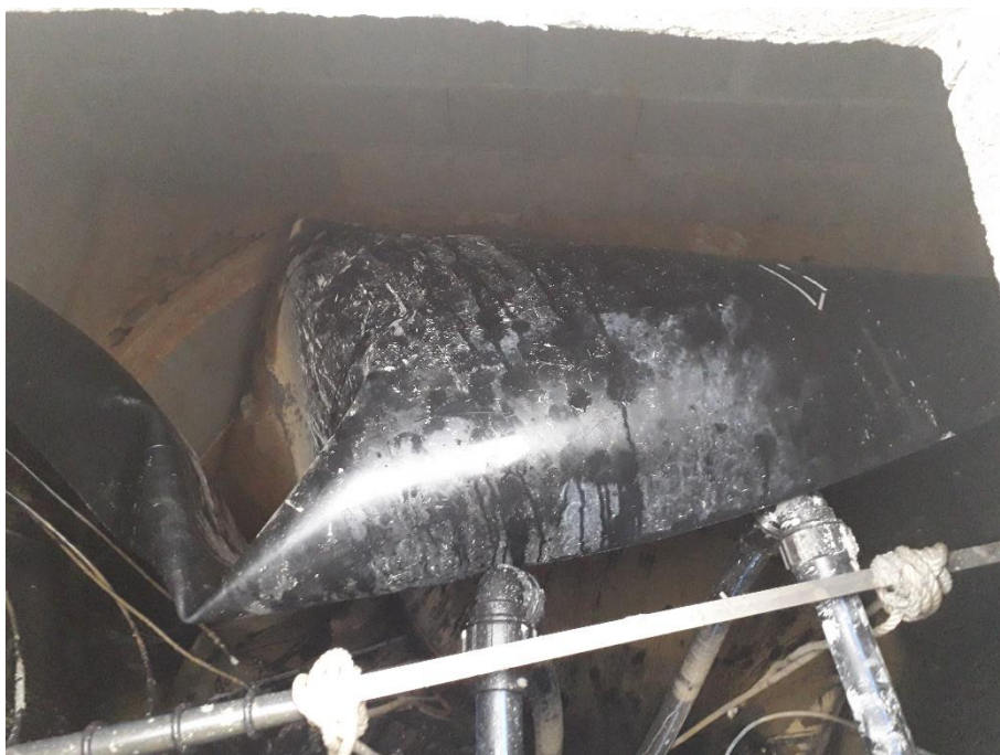
Estação elevatória (antes da intervenção)
