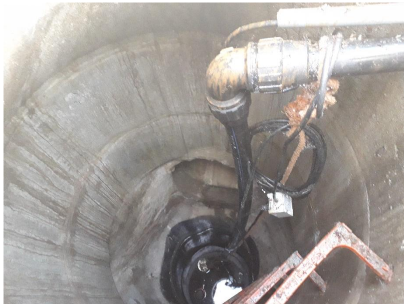
Placa PEAD aplicada no rebaixamento da caixa e sistema de bombagem
