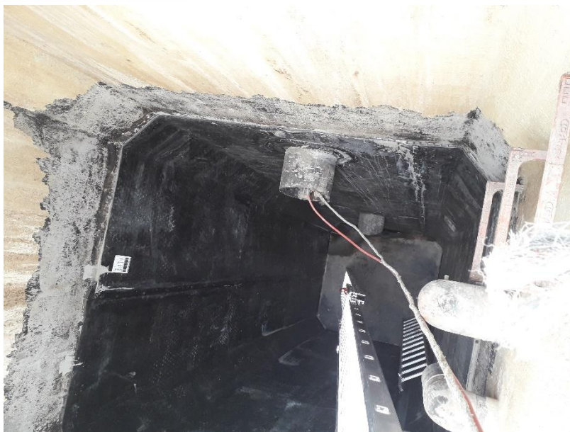
Estação elevatória com revestimento em placa PEAD (final da intervenção)
