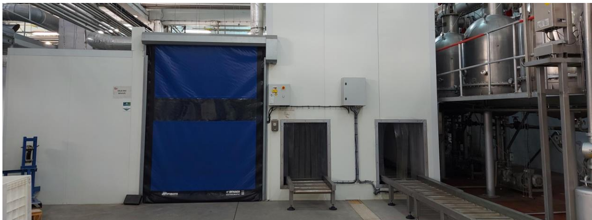
Figura 53- Registo fotográfico da entrada da Sala de abertura.
