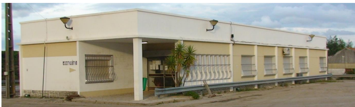
Figura 3- Registo fotográfico do edifício demolido.
