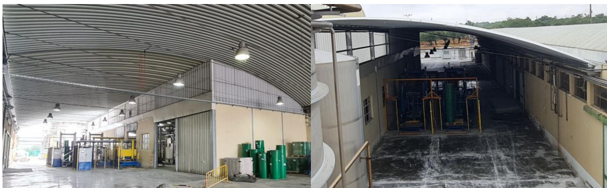
Figura 12 - Registo fotográfico do edifício 2- Produção e Armazenagem, depois da requalificação e ampliação.
