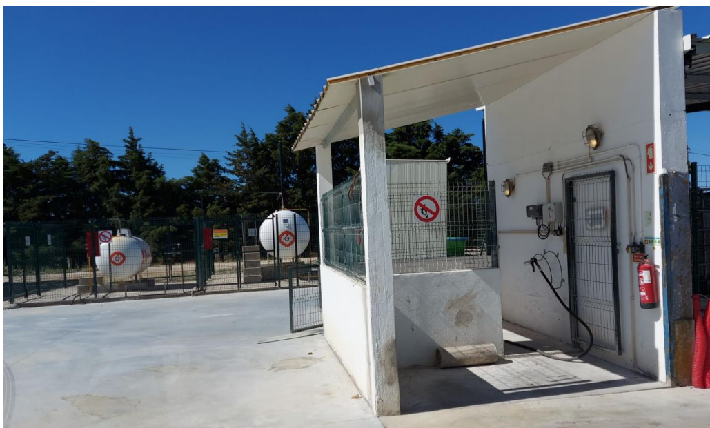
Figura 19 – Registo fotográfico do edifício de apoio à armazenagem de GPL – Edifício Yb.
