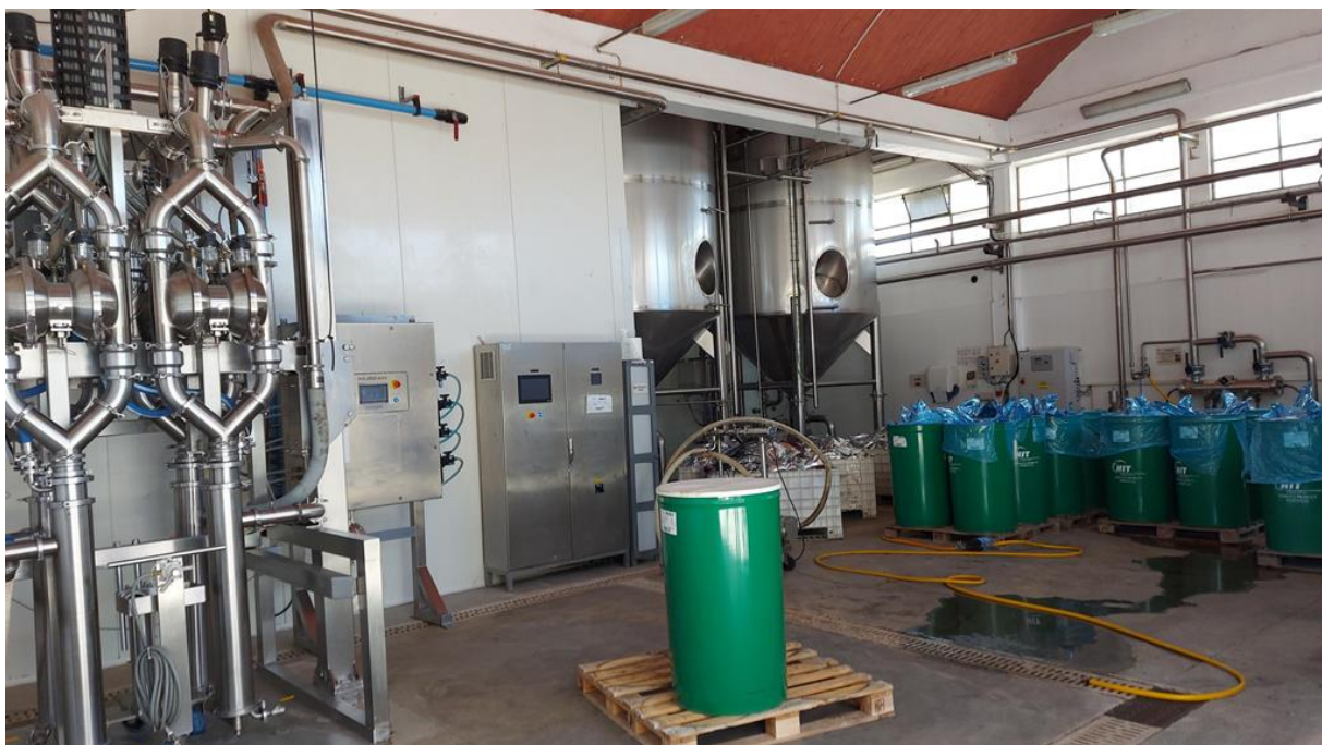
Figura 50- Registo fotográfico da sala de rework.
