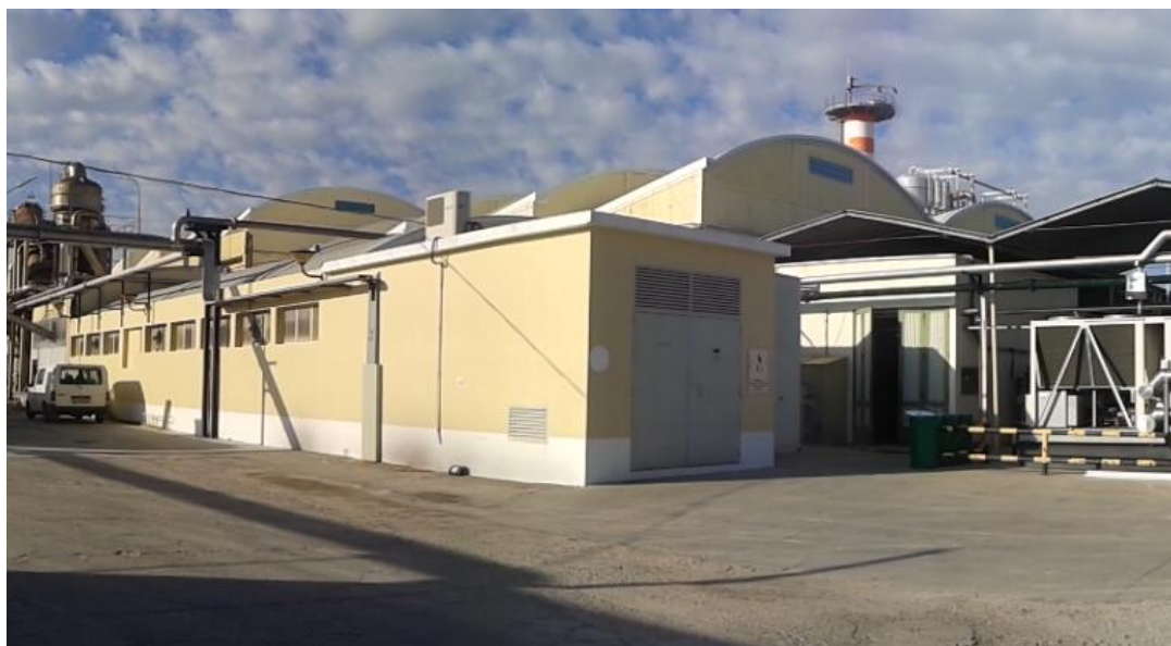
Figura 55 - Registro fotográfico do edifício antes da instalação dos chillers.
