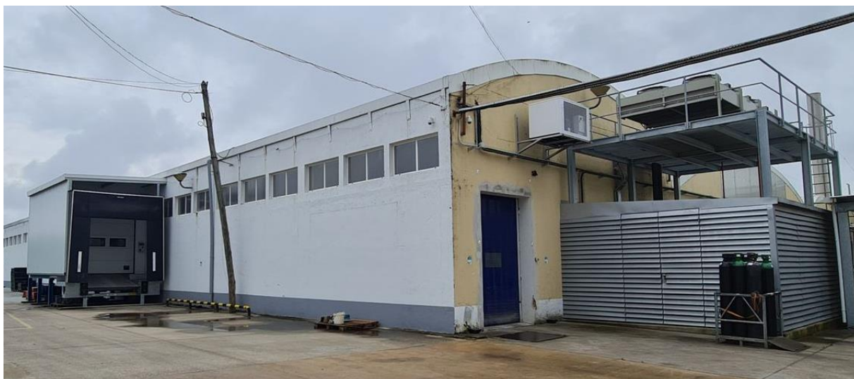
Figura 42 -Registo fotográfico da câmara frigorífica depois das alterações.
