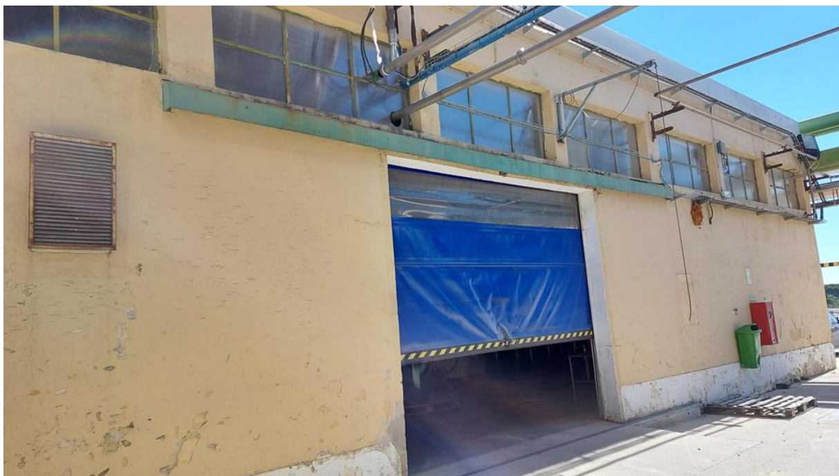
Figura 49- Registo fotográfico do edifício onde se encontra a sala de rework.
