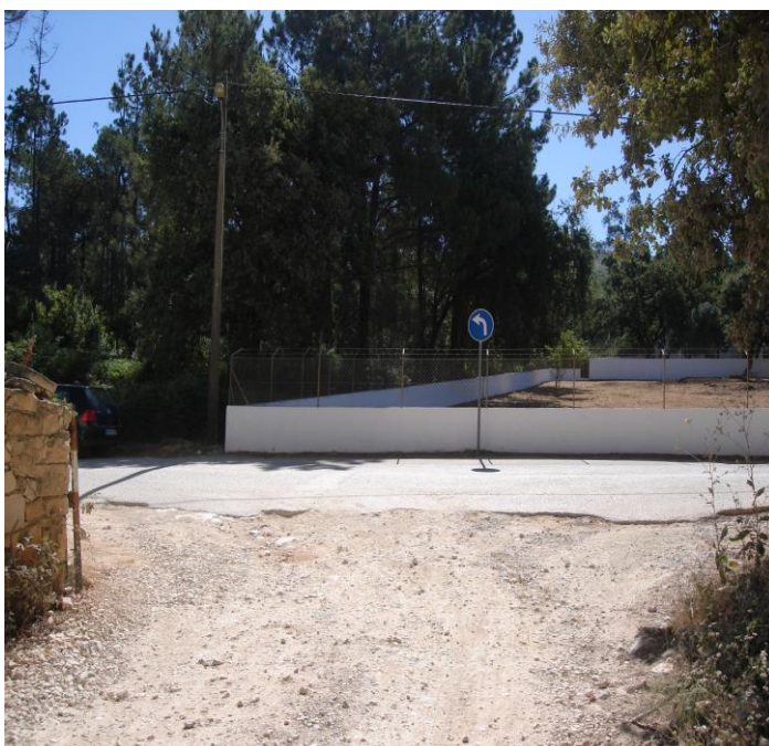
Foto1- Entrada/saída da pedreira “Cavada N.º2” pelo acesso definido no setor mais a nascente da pedreira, com sentido de obrigatoriedade à esquerda em direção à EN1/IC2, sempre por pavimento de betuminoso.
