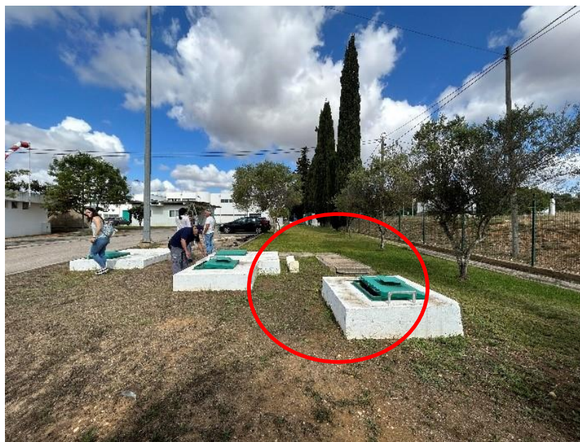
Figura 4.11 – Ligação na ETA das Fontainhas
