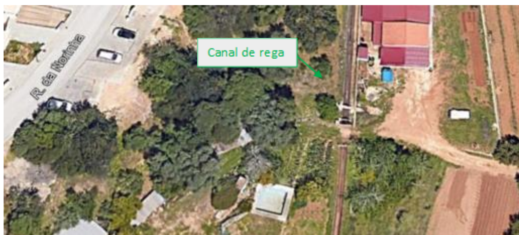
Figura 4.5 – Local da travessia do canal de rega 1 (fonte: Google Earth)
