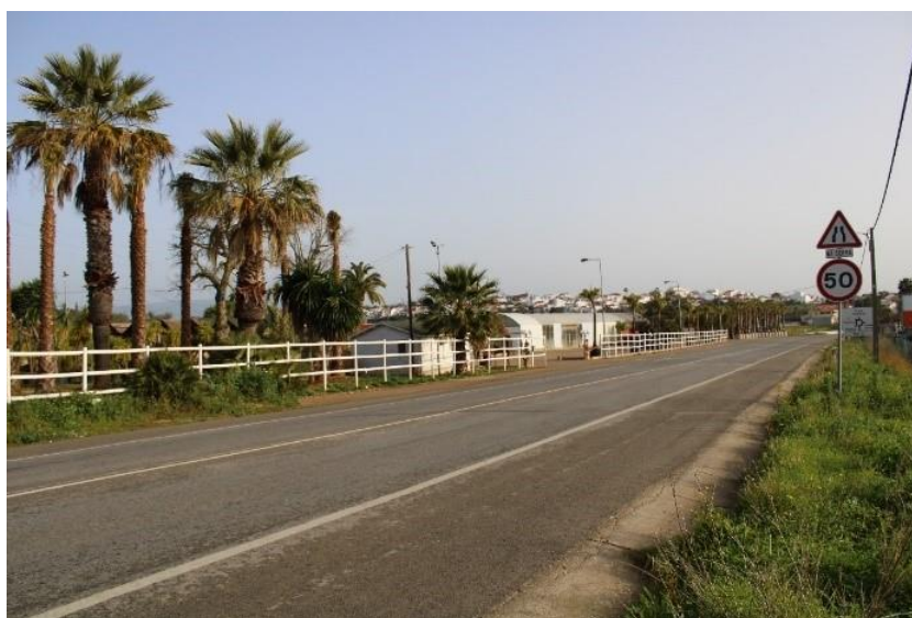
Figura 4.8 – Local da cravação horizontal a jusante da Ribeira de Farelo para travessia da EN125
