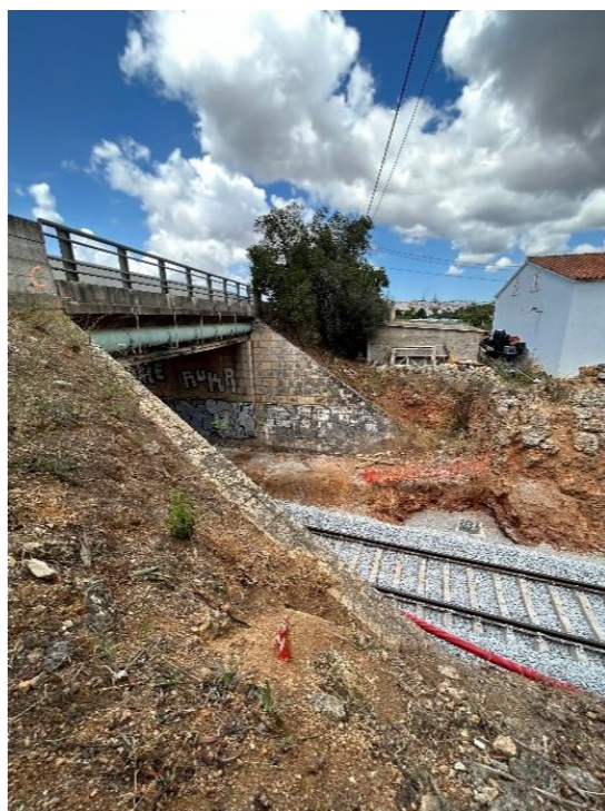
Figura 4.6 – Local da travessia da linha de caminho-de-ferro
