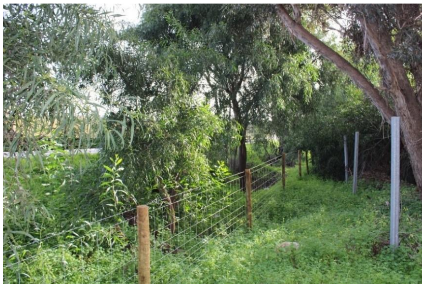
Figura 4.3 – Local da cravação horizontal a jusante da Câmara da Penina para a travessia da EN125
