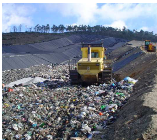
Figura 11 – Equipamento de compactação
