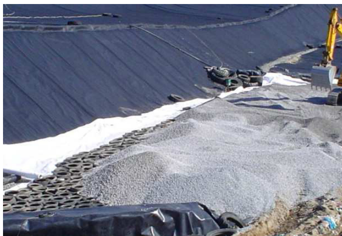
Figura 8 – Nova célula preparada para a deposição.
