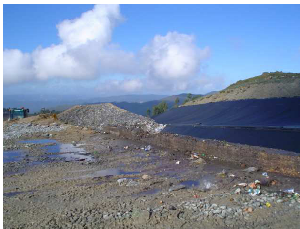
Figura 5 – Plataforma de deposição com estrutura em betão armado.
