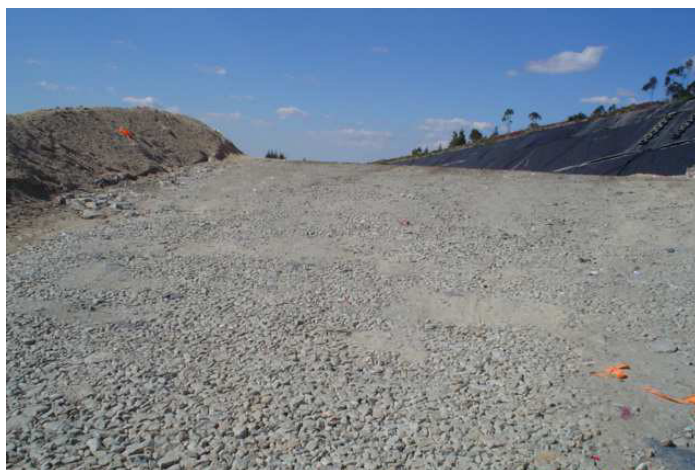
Figura 3 – Acessos à área de deposição.
