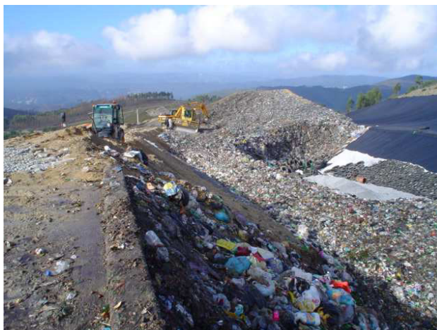
Figura 7 – Frente de deposição de resíduos.
