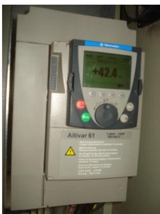
Figura 5.20 – Variador eletrónico de velocidade da marca Telemecanique, modelo Altivar 61 – 7,5 kW
