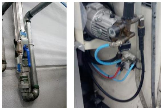
**Figura 6.7 – Exemplos de fugas detetadas na rede de Ar Comprimido**
