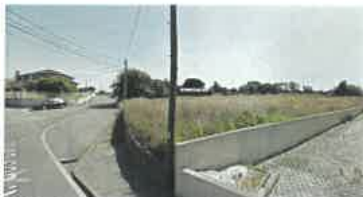
Imagem 10 : Cruzamento rua das quintas e rua dos campinhos
