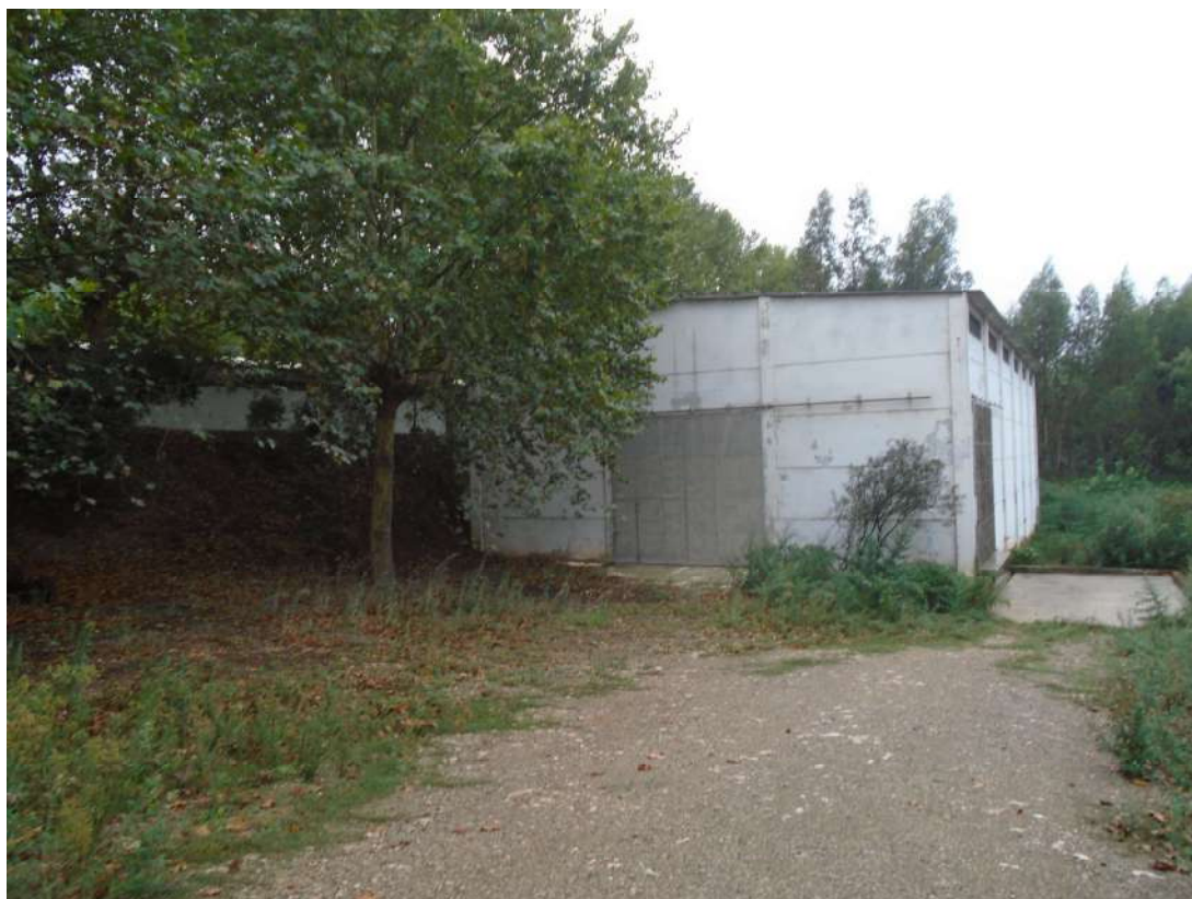
Figura 10 – Vista geral pavilhão de estrume (AID) - Área 1.
