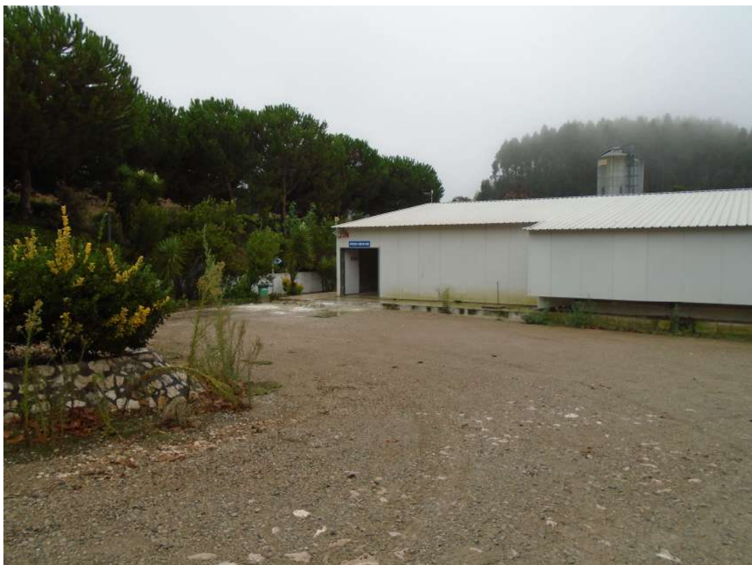
Figura 9 – Vista geral do pavilhão 1 (AID) - Área 1.
