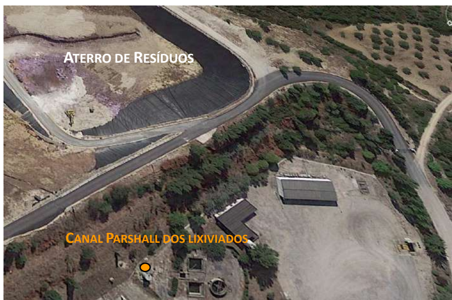
Figura 1 – Localização do canal Parshall dos lixiviados em relação ao Aterro
