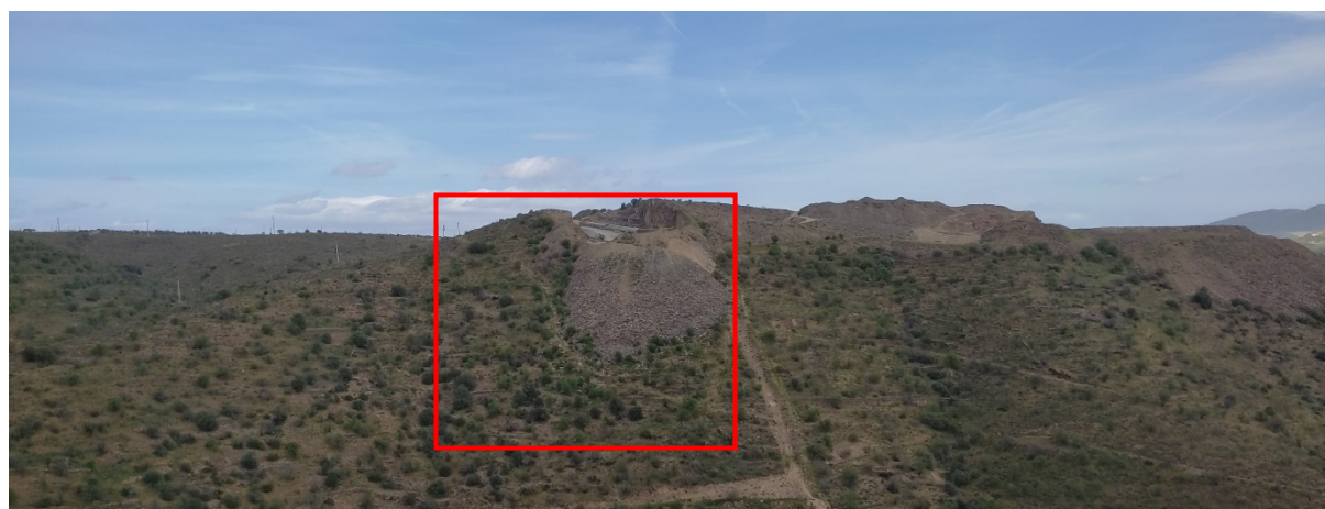
Figura 48: Ponto de observação PV10 (caminho rural, a sul da Pedreira n.º 6637 “Vale de Videiro II”). O polígono vermelho identifica a área do Projeto.
