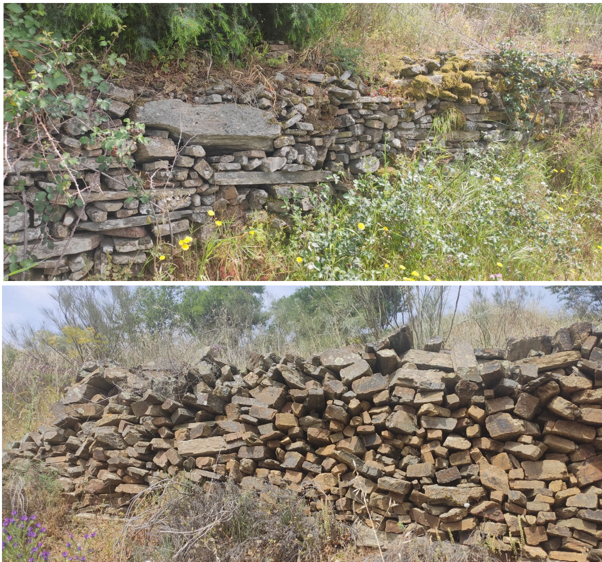
Figura 63: Muros de socalco feitos de placas de xisto, existentes na encosta meridional.
