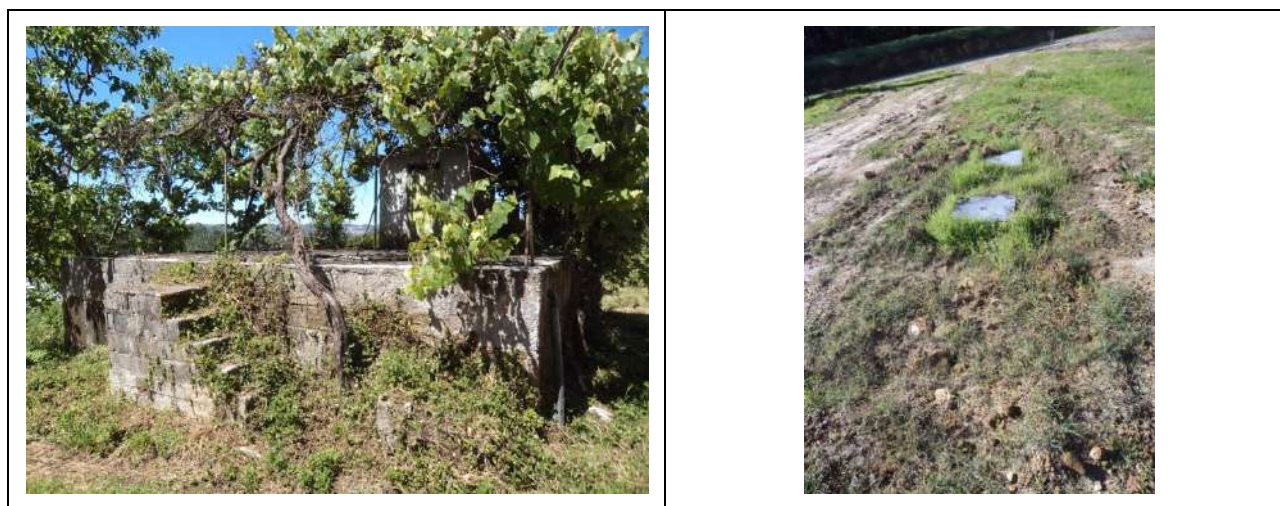
Figura 7 – Depósito de água sobrelevado (à esquerda) e poço absorvente da fossa ES2 (águas residuais domésticas).
