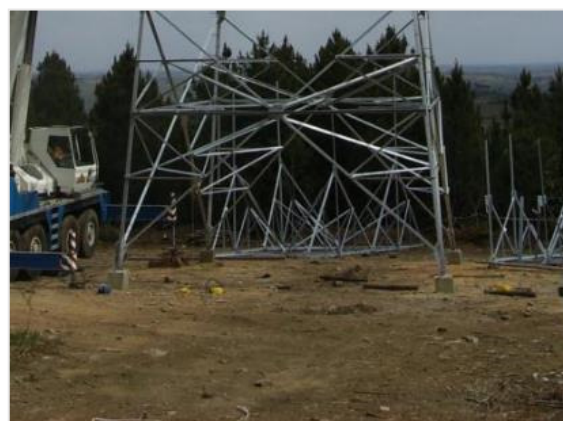
Recobrimento integral da área escavada com as terras escavadas, sem terras sobrantes
