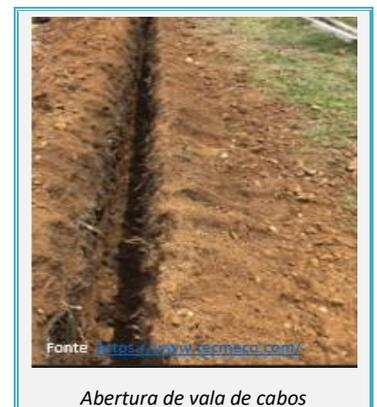
As terras resultantes da escavação são provisoriamente armazenadas na proximidade da vala sendo usadas na sua cobertura ou, caso seja necessário, no local destinado para depósito temporário de terras para utilizar, posteriormente, na regularização final do terreno.
