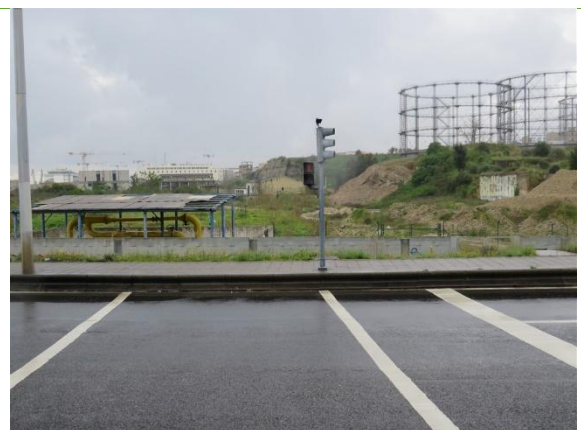
Detalhe de infraestruturas na antiga parcela industrial, junto à rotunda, a nascente do traçado.
