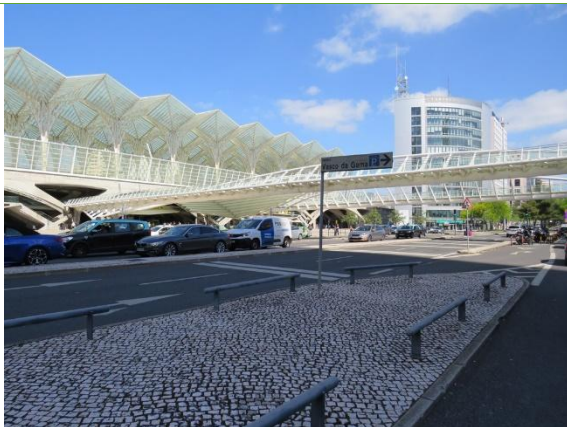
Av. Dom João II, ligação pedonal superior entre Gare Oriente e Centro Comercial Vasco da Gama.
