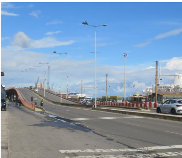
Viaduto da Av. Infante Dom Henrique / Av. Mouzinho de Albuquerque.
