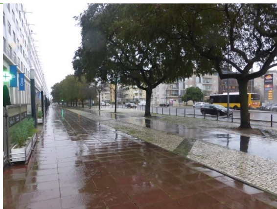
Vista da Alameda dos Oceanos, com paragem junto ao Posto de abastecimento Repsol.
