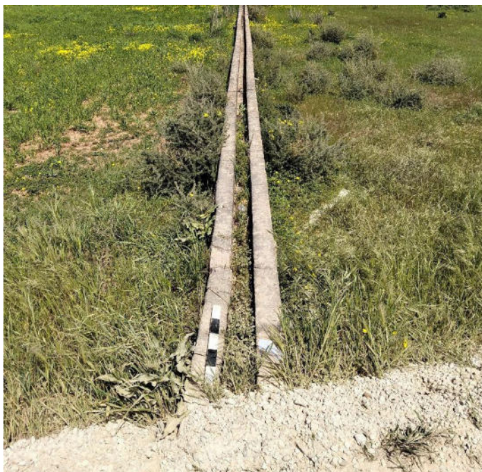
Figura 55. Troço canalização - Alfamar 5.
