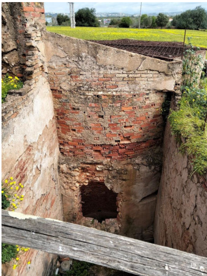
Figura 29. Detalhe da parede exterior do Poço.
