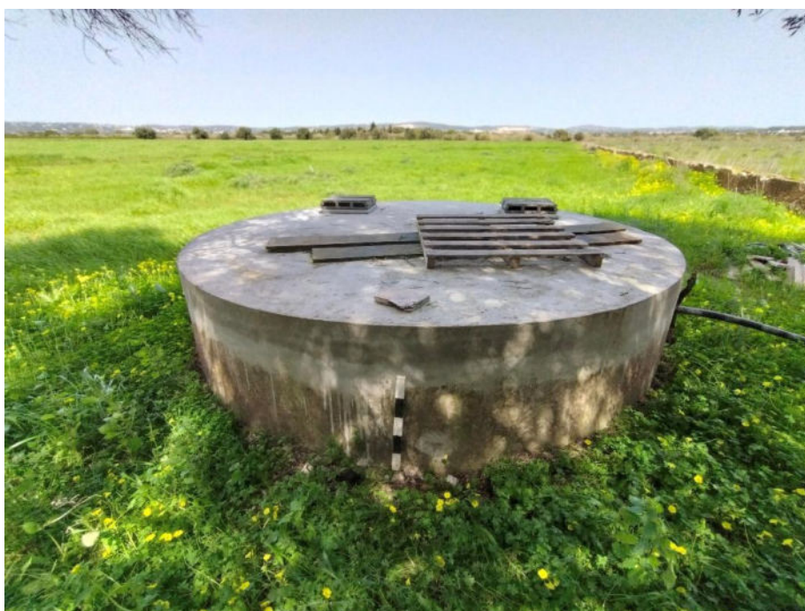
Figura 54. Cisterna associada a Casa e sistema hidráulico de Foros de Quarteira.
