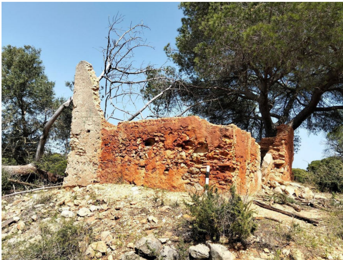
Figura 51. Perspectiva geral Ruína da Praia da Falésia.
