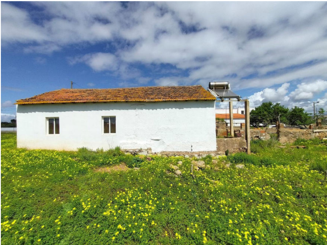
Figura 28. Casa agrícola da Ponte do Barão.
