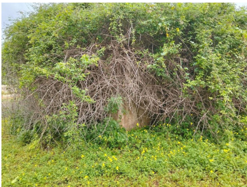
Figura 41. Casa agrícola Barão 7, quase completamente coberta de vegetação.
