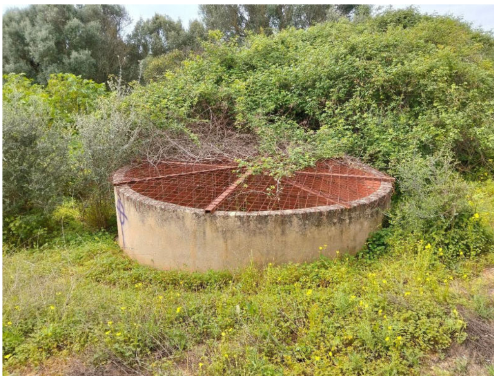
Figura 42. Poço associado à cada agrícola Barão 7.
