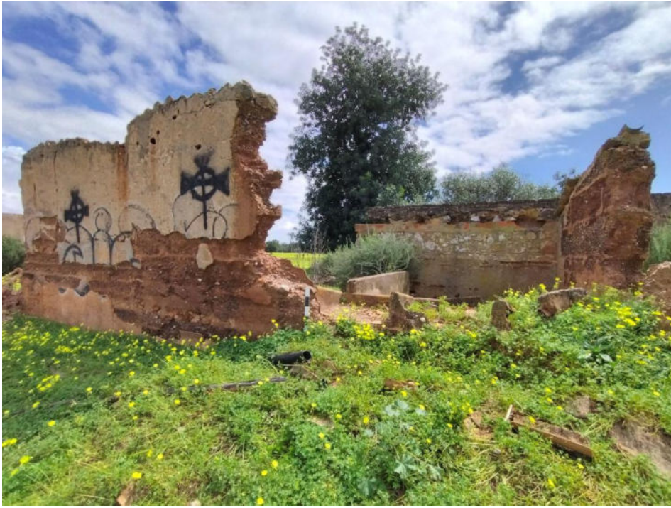
Figura 30. Ruínas da casa agrícola.
