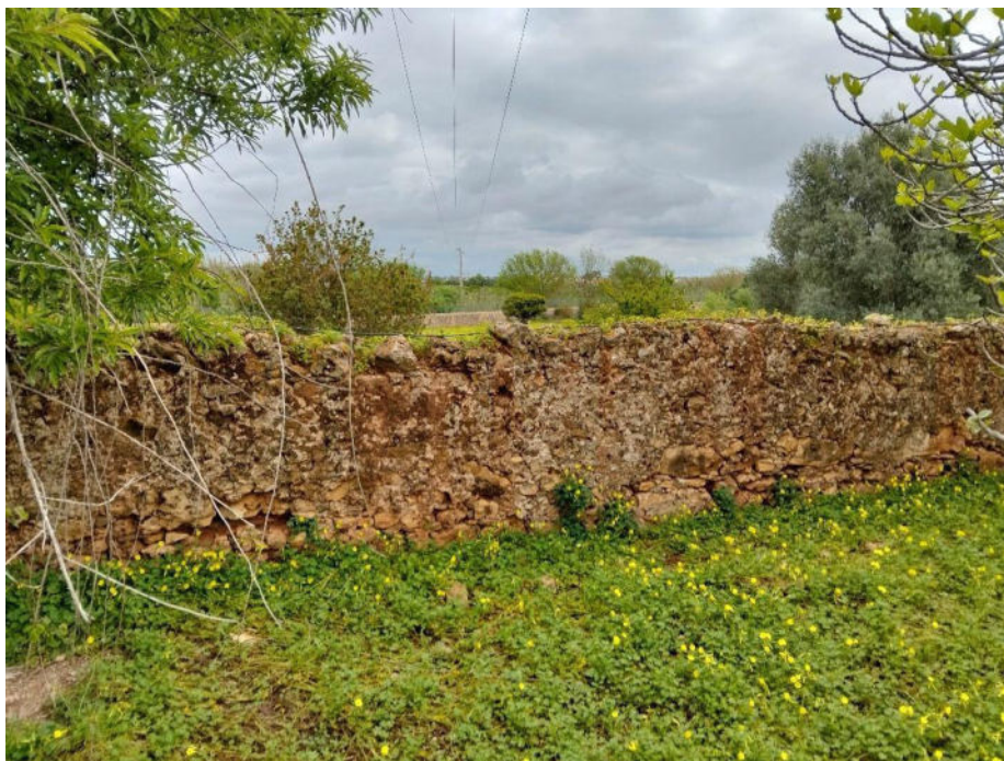
Figura 39. Vista parcial Barão 5.
