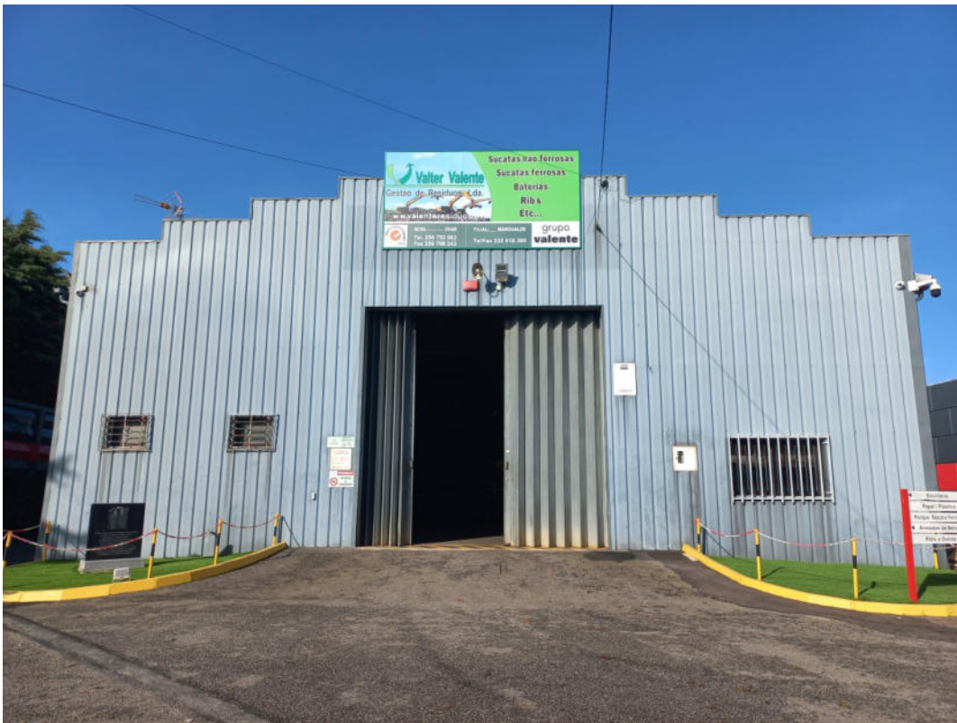
Fig.1 – Instalações da Valter Valente (Vista E-SE/O-NO).
