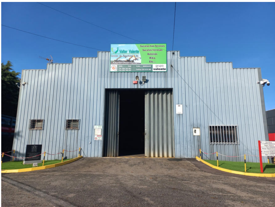
Foto 1 – Unidade de Operação da Valter Valente (Vista E-SE/O-NO).
