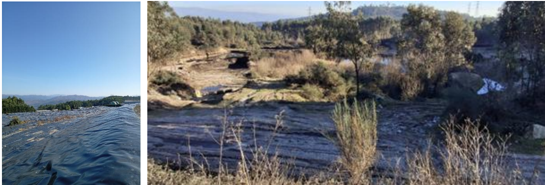
Figura 6 - Perspetiva geral da área de reengenharia (à esquerda) e da área de ampliação do aterro (à direita).
