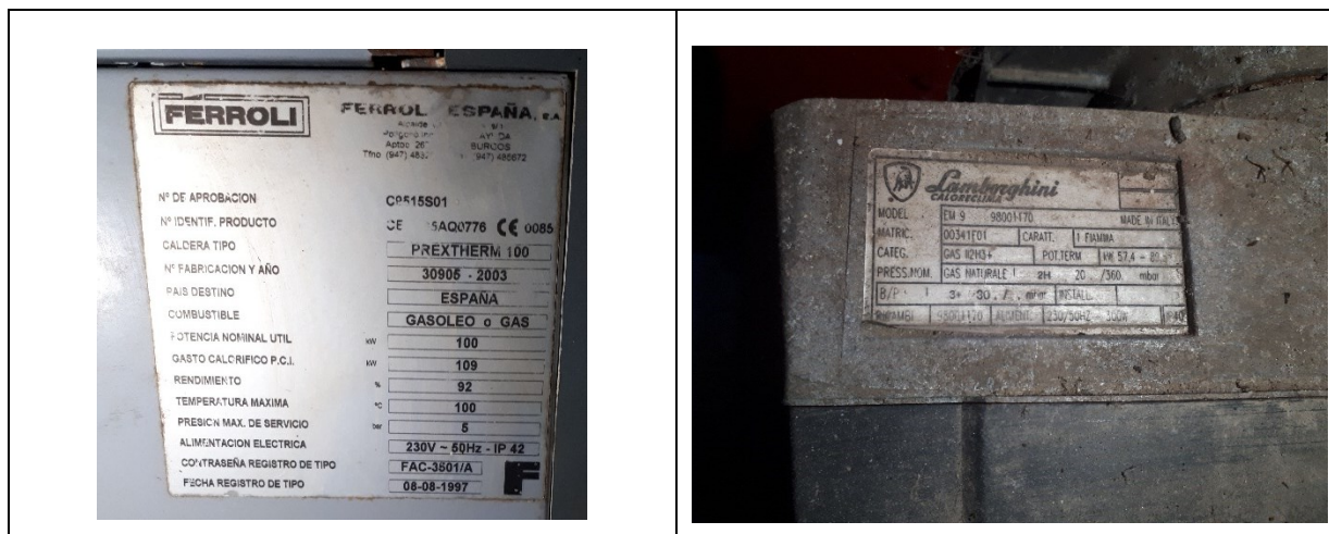
Figura 2.1 e Figura 2.2- Chapa dos geradores de ar quente com as características dos mesmos dos núcleos de Valinhos e de Sarruadas, respetivamente.
