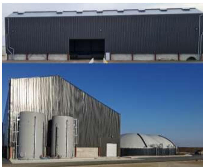
Fotografia 4.4 – Exemplo de edifício de exploração
