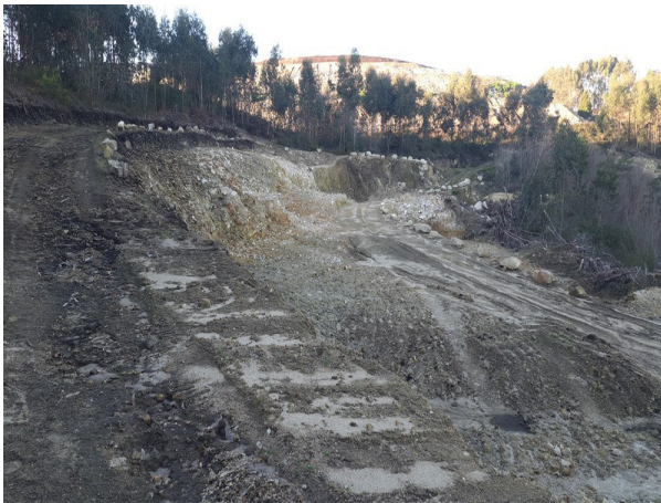
Fig. 7: Vista geral da área do projeto, de sul para norte, desaterrada.
