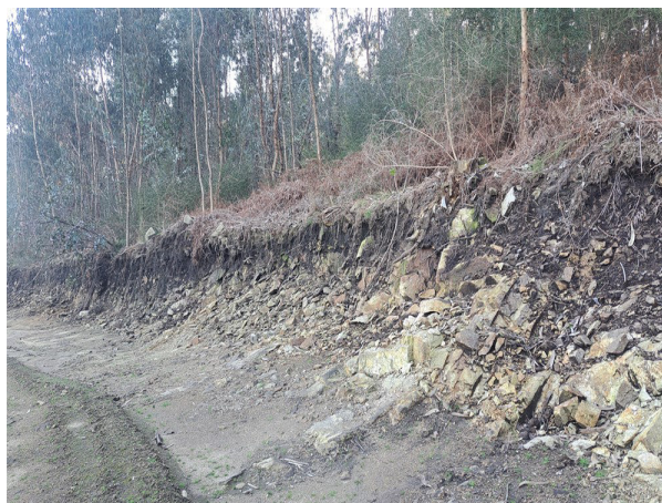
Fig. 4: Extremo oeste da área do projeto - talude dos desaterros.
