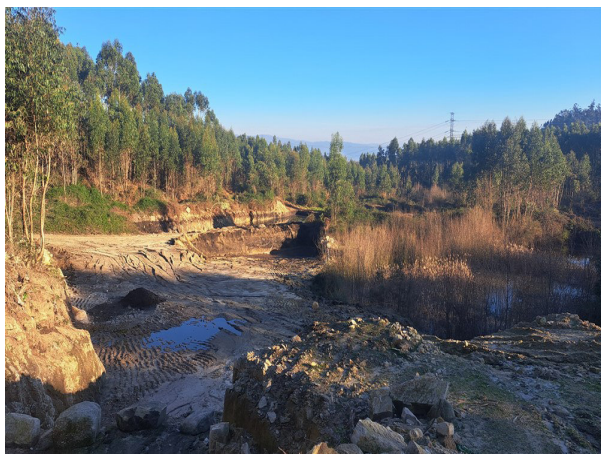
Fig. 3: Vista geral da área do projeto, de norte para sul, desaterrada.
