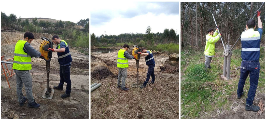
Figura 6 – Fotos ilustrativas do decorrer dos trabalhos executados.
