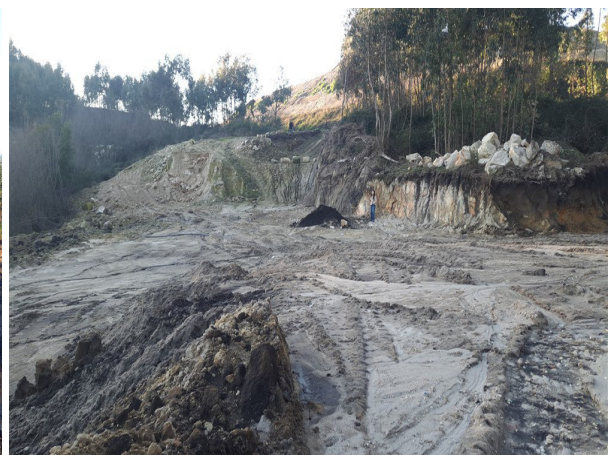
Fig. 10: Vista geral da área do projeto, de sul para norte – desaterrada.
