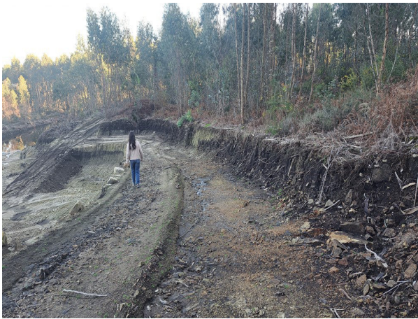
Fig. 5: Área do projeto, extremo oeste – área desaterrada.
