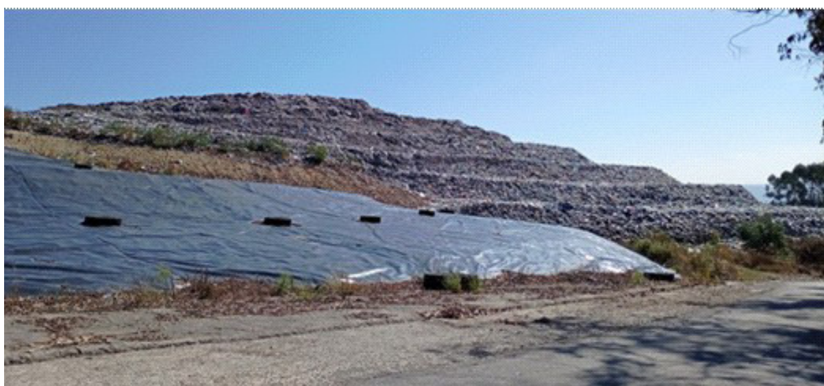
Fig. 13, 14: Panorâmica em cima (a norte) e em baixo (a sul) do local destinado à reengenharia do aterro.
