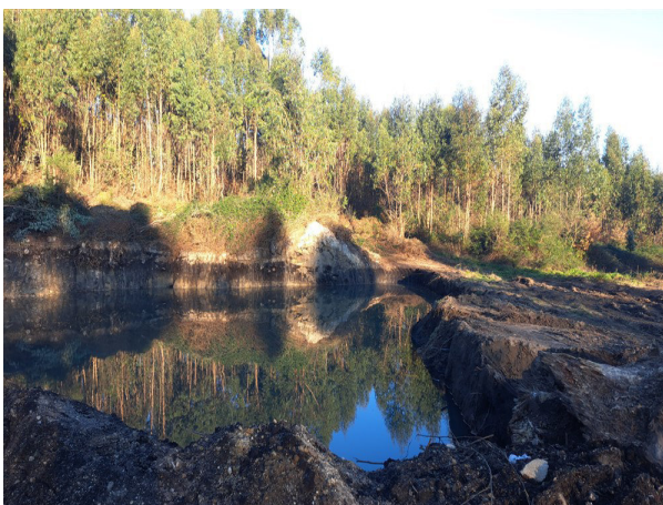
Fig. 9: Vista geral da área do projeto, ao centro, desaterrada.
