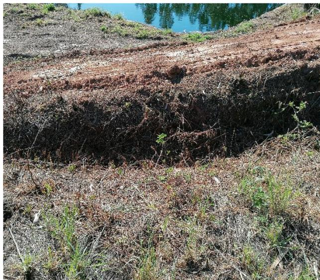
Rede de Águas Pluviais - Valas escavadas na terra para recolha e encaminhamento à linha de água
