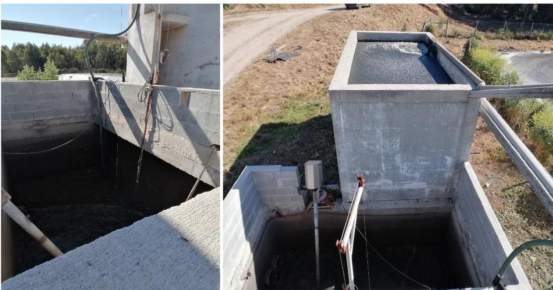
Tanque de receção (equipado com agitador) e tanque de remoção de areias
