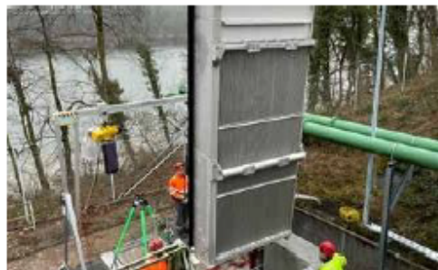
Instalação de um RakeMax® durante a modernização da estação.
